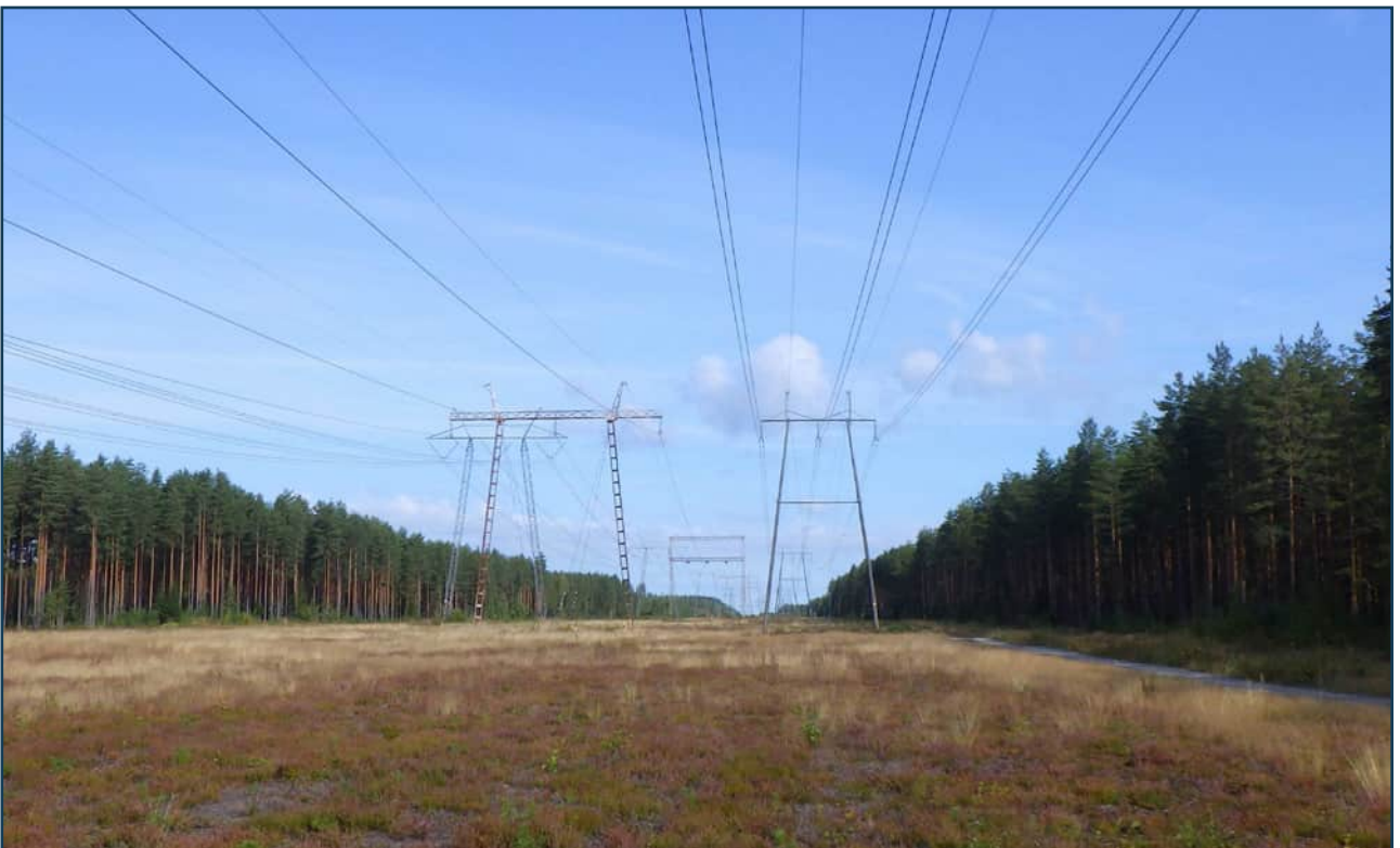
Kuva 9. Voimajohtoreitti VE2 Haaralantieltä pohjoiseen .
