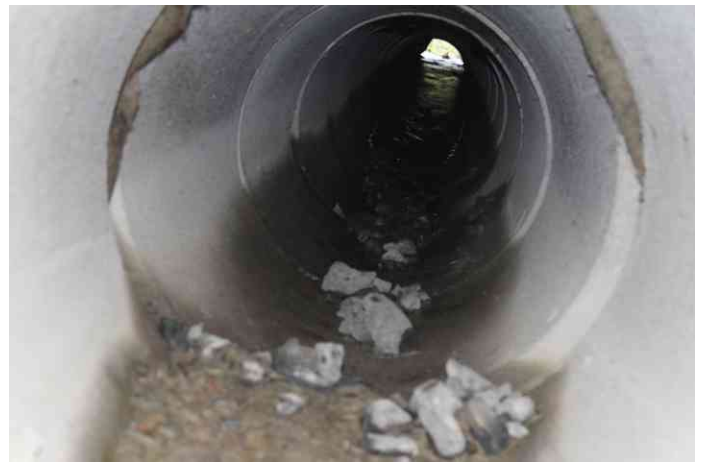
Kuva 5: B600 Rumpun imupää, putkessa lietettä keskellä.
