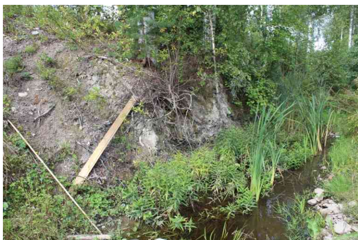
Kuva 39. Kuolemajärven purku uoman luiskat ovat osin syöpyneitä.
