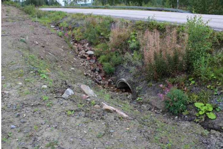
Kuva 8. B1200 rummun imupään eteen kasaantunut lohkareita.
