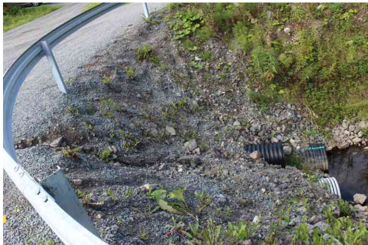
Kuva 37. Haapanantien alitus putket, purkupää.
