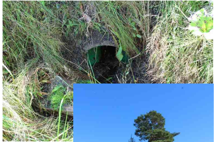
Kuva 23. Alitusrumpu M315 tukossa/tukittu kivellä(IMG_2030)
