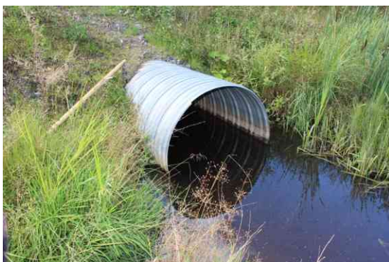
Kuva 43 ja 44. Putkituksen purkupää. Putkitus muuttuu jossakin vaiheessa Ø 1200T rummuksi. Purkupäässä putkessa vettä 55cm.
