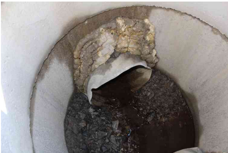
Kuva 22. Länsi-Himoksen tien alittava uoman imupää on pusikoitunut ja ei ole selvästi havaittavissa.(IMG_2027)
