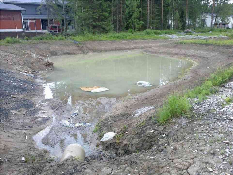
Kiintoaineksen laskeutusaltaalla suojaamattomat luiskat lisäävät altaan kuormitusta.
