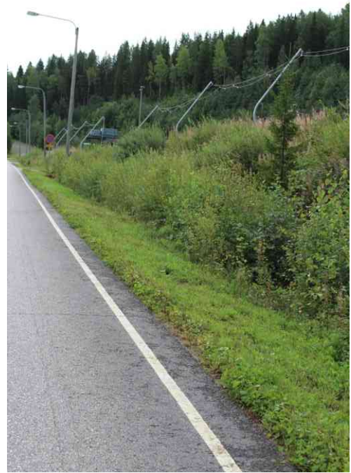
Kuva 13. Imupuolen uomat pusikoituneet.
