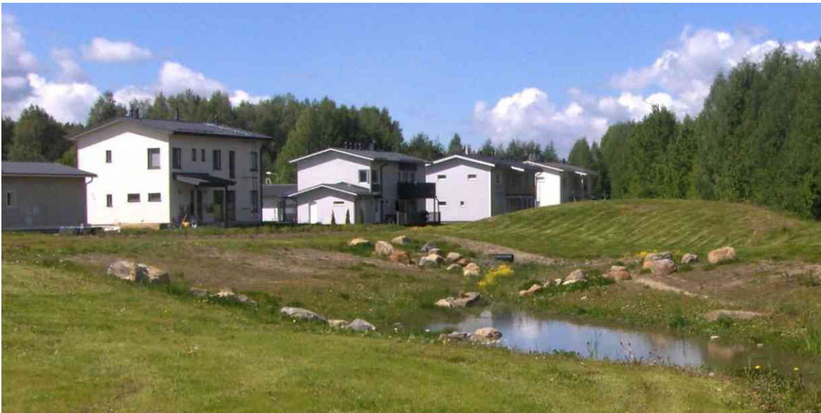
Yllä: Rambollin suunnittelema hulevesien luonnonmukainen viivytysalue Vaarinmaalla, Kangasalla vuosi rakentamisen jälkeen. Käsittelyalueella yhdistyy pysyvän veden alue sekä sitä ympäröivä tulvaniittyalue. [1]
