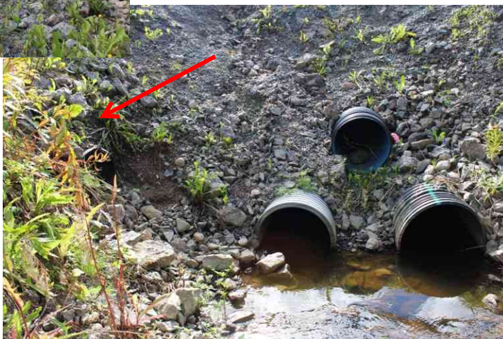
Kuva 38. Haapanantien alitus putket, purkupää. Uomaan purkaantuu vesiä myös asutusalueelta (punainen nuoli).
