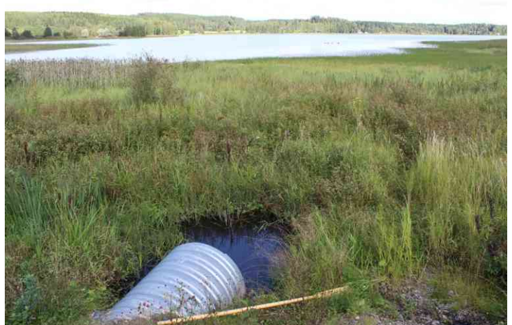
Kuva 43 ja 44. Putkituksen purkupää. Putkitus muuttuu jossakin vaiheessa Ø 1200T rummuksi. Purkupäässä putkessa vettä 55cm.
