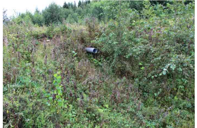
Kuva 15. Ajouran alittava rumpu M315 on tukkeutunut.
