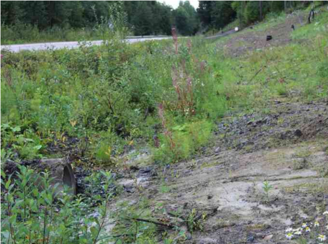
Kuva 4. B600rumpun yläpuolelle rakenteilla asuinalue
