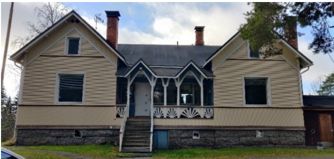
Kuva 19. Päärakennuksen koillissivua (lokakuu 2022).
