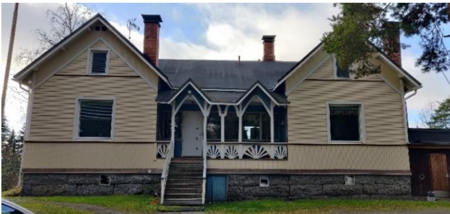
Kuva 19. Hartusvuoren tilan päärakennuksen koillissivu (lokakuu 2022).
