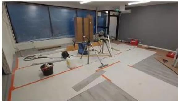
Jämsä Tehdas on pian remontoitu, ja sitten alkaa kalusteiden odotus. KUVA: PETTERI KOSKINEN
