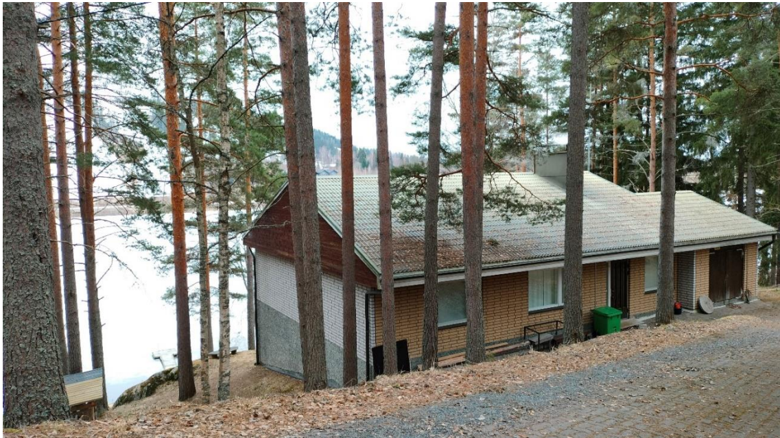
Kuva 44 1970-luvun rakennuskantaa Himosrannasta. Taustalla Pohjois-Himoksen laskettelurinteet.
