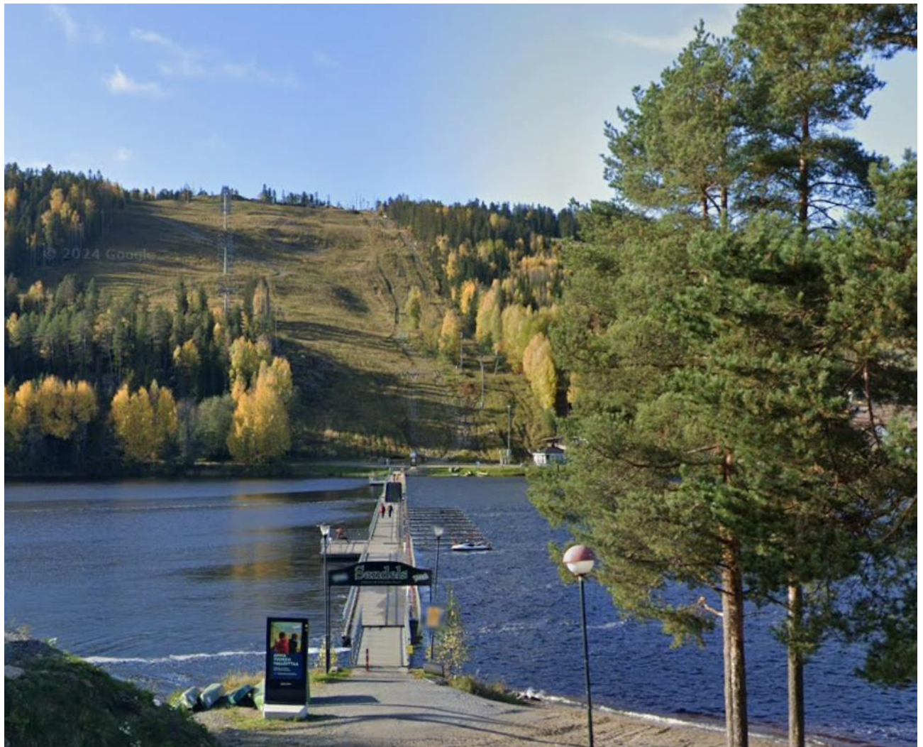
Kuva 5.24 Esimerkkikuva Nilsiä Tahkolta vesistön ylittävästä kevyenliikenteen sillasta. Kuva: Google. (2023). Google Maps. Haettu osoitteesta https://maps.google.fi/
