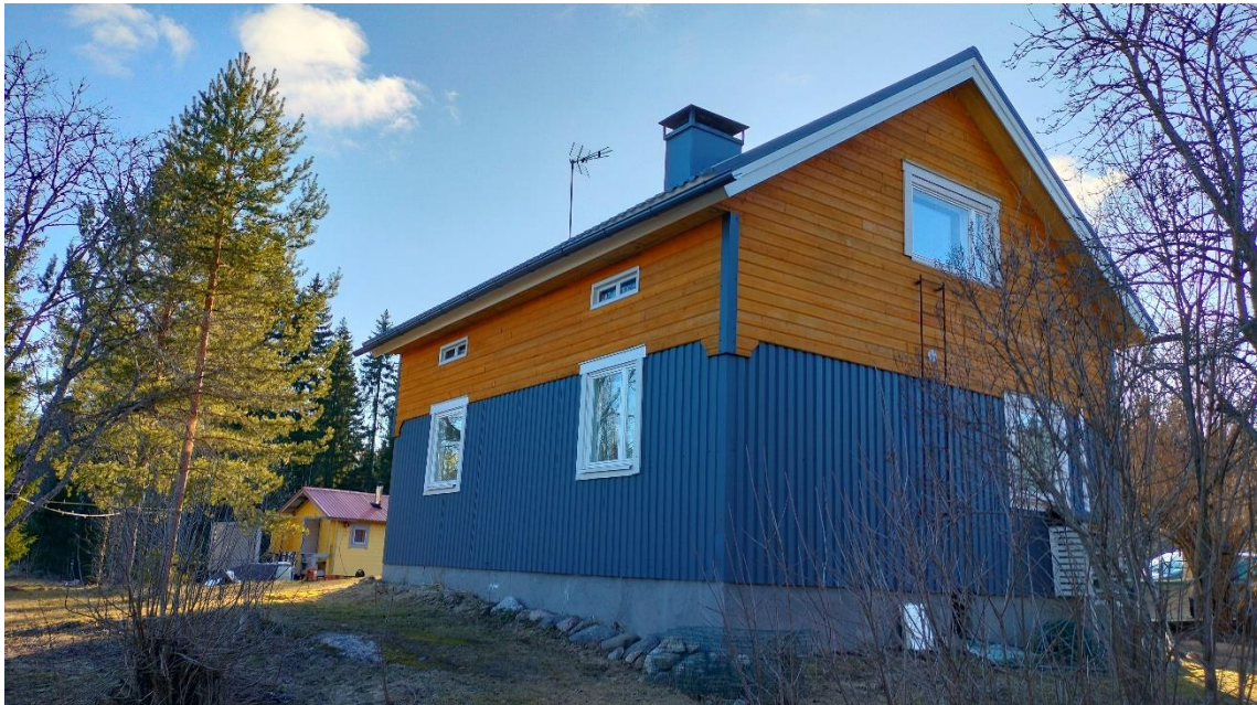
Kuva 57 Kumpulan tilan päärakennus on rakennettu vuonna 1949, mutta sen julkisivu on muutettu täysin. Julkisivu on verhoiltu rakennuksen alakerran osalta tummanharmaalla muotopellillä, joka muistuttaa ulkonäöltään pystypanelointia. Rakennuksen yläosa on verhoiltu lämpimänsävyisellä keltaisella vaakapaneelilla.
