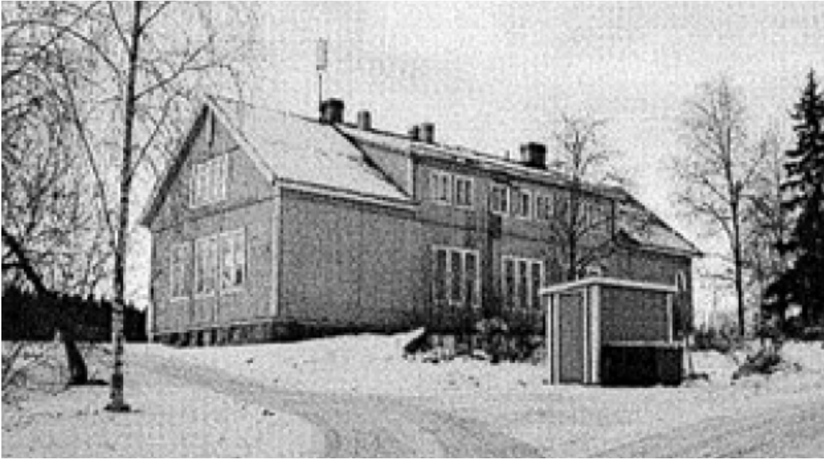
Kuva 35: Säyrylän koulu on paikallisesti merkittävä rakennetun ympäristön kohde, ja se on rakennettu vuonna 1923 Säyrylän-tien ja Patalahden väliselle rantatörmälle.
