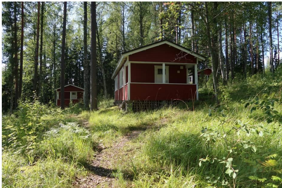
Kuvat 19 Leheksen kiinteistöllä 182-427-4-25 on ollut UPM:n henkilökunnan käytössä ollut mökkikylä. Rakennukset eivät nyt ole käytössä (Kuvat (3 kpl): Kimmo Mustonen 25.8.2023)
