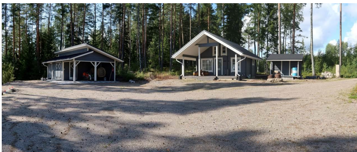
Kuva 17 Kaksi kuvaa korttelin 1 rakennuspaikan 2 rakennuksista (Kuvat: Kimmo Mustonen 25.8.2023)
