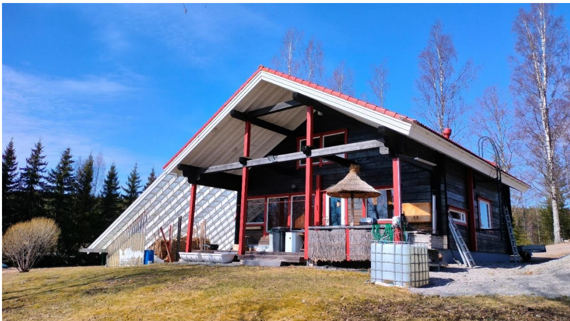
Kuva 56 Vanhan Ahon tilan mailla sijaitseva lamellihirsirakenteinen omakotitalo, joka on rakennettu 2010 (RHR). Rakennuksen länsisivulla on suuri maahan asti ulottuva valokate.
