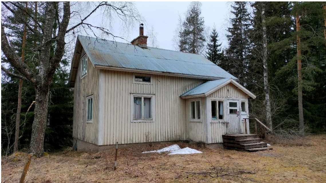
Kuva 30 Kallion/Kalliomäen tilan päärakennus. Rakennus on RHR:n tietojen mukaan rakennettu vuonna 1952, mutta rakennus näkyy paikoillaan jo vuoden 1949 ilmakuvassa. Hahmoltaan rakennus on tyyppinen jälleenrakennuskauden tyyppitalo.
