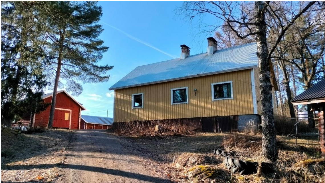
Kuva 36 Hietämäen vanhempi päärakennus nykyasussaan on peräisin 1940- ja 1950-luvun taitteesta maanomistajan mukaan. Jykevistä porakiviperustuksesta päätellen samalla paikalla on saattanut sijaita jo ennen nykyistä asuinrakennusta tilan vanha päärakennus. Nykyistä päärakennusta on pohjoisen puolelta laajennettu ns. elintasosiivellä. Nykyisen päärakennuksen lisäksi pihapiirissä sijaitsee uudempi, 2000-luvun alussa rakennettu omakotitalo. Pihapiirissä on edelleen käytössä olevia talousrakennuksia, jotka ovat peräisin 1800- ja 1900-luvuilta.
