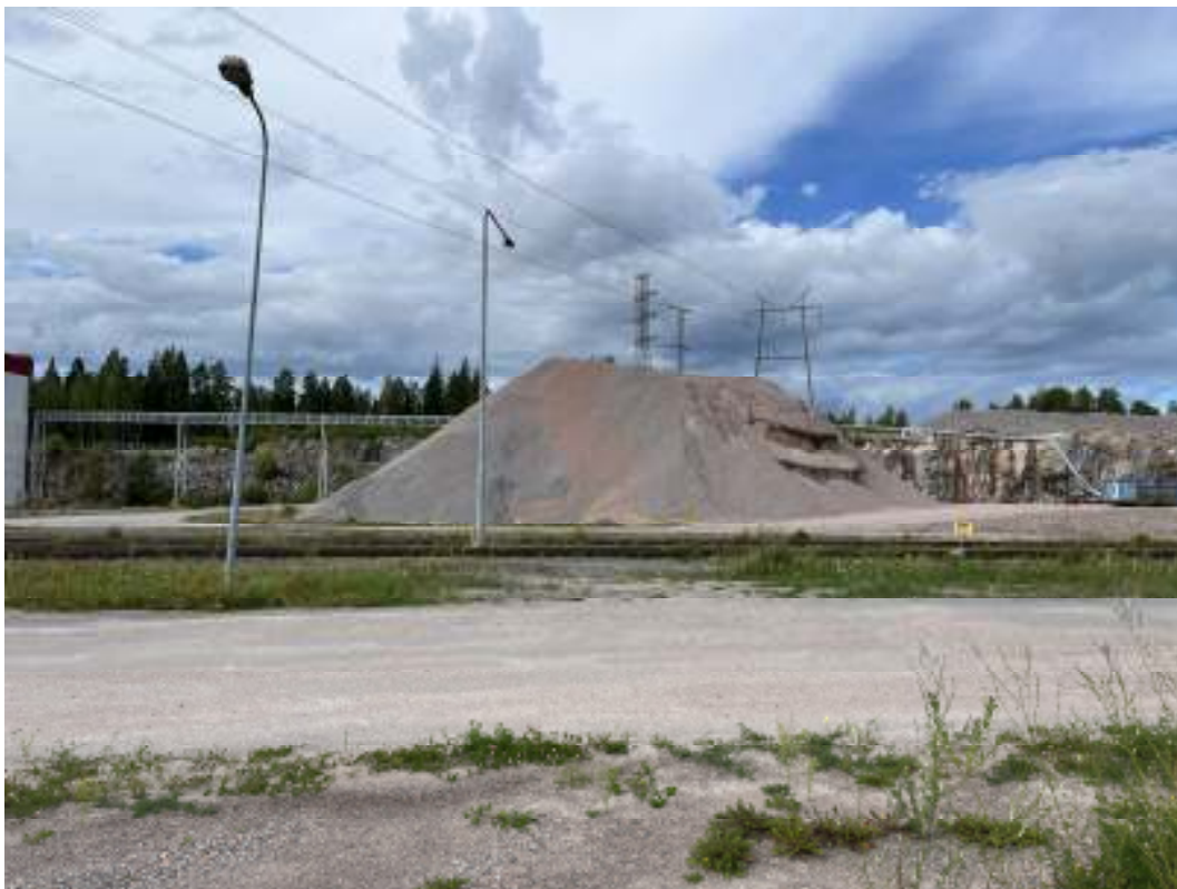
Kuva 2. Varastoalue ottamisalueen länsipuolella. Varastokasan vasemmalla puolella näkyy vanha louhintaluiska ja kuvan oikeassa reunassa uutta leikkausta.
