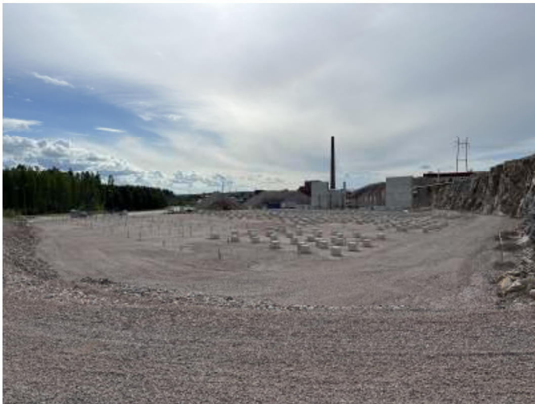
Kuva 9. Louhitun alueen pohjalle asennettuja betonirakenteita.
