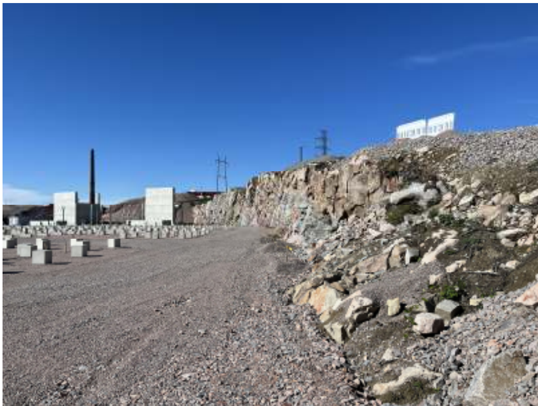
Kuva 3. Ottamisalueen rintausten louhinnan jälkeen, kuvattuna idästä lännen suuntaan.
